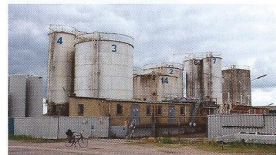
Foto fra 2013 - Tankene nr. 1 - 7 er de oprindelige tanke. I de senere år har tankene været hvidmalede, selvom det er svært at se for rust og alger.
