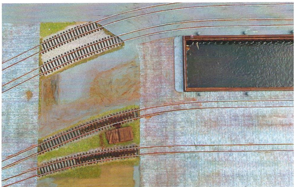
Det hele set lidt fra oven. Vi er her omkring 1985, hvor alle bygninger er fjernet, og arbejderne sidder på kanten og venter på de første lastbiler med opfyld.
