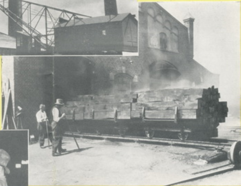
Sveller kan ikke modstaa Vind og Vejr, før de er blevet imprægneret, det sker ogsaa i Horsens.
